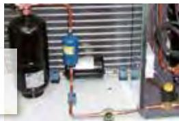
Silenciador en descarga del compresor
